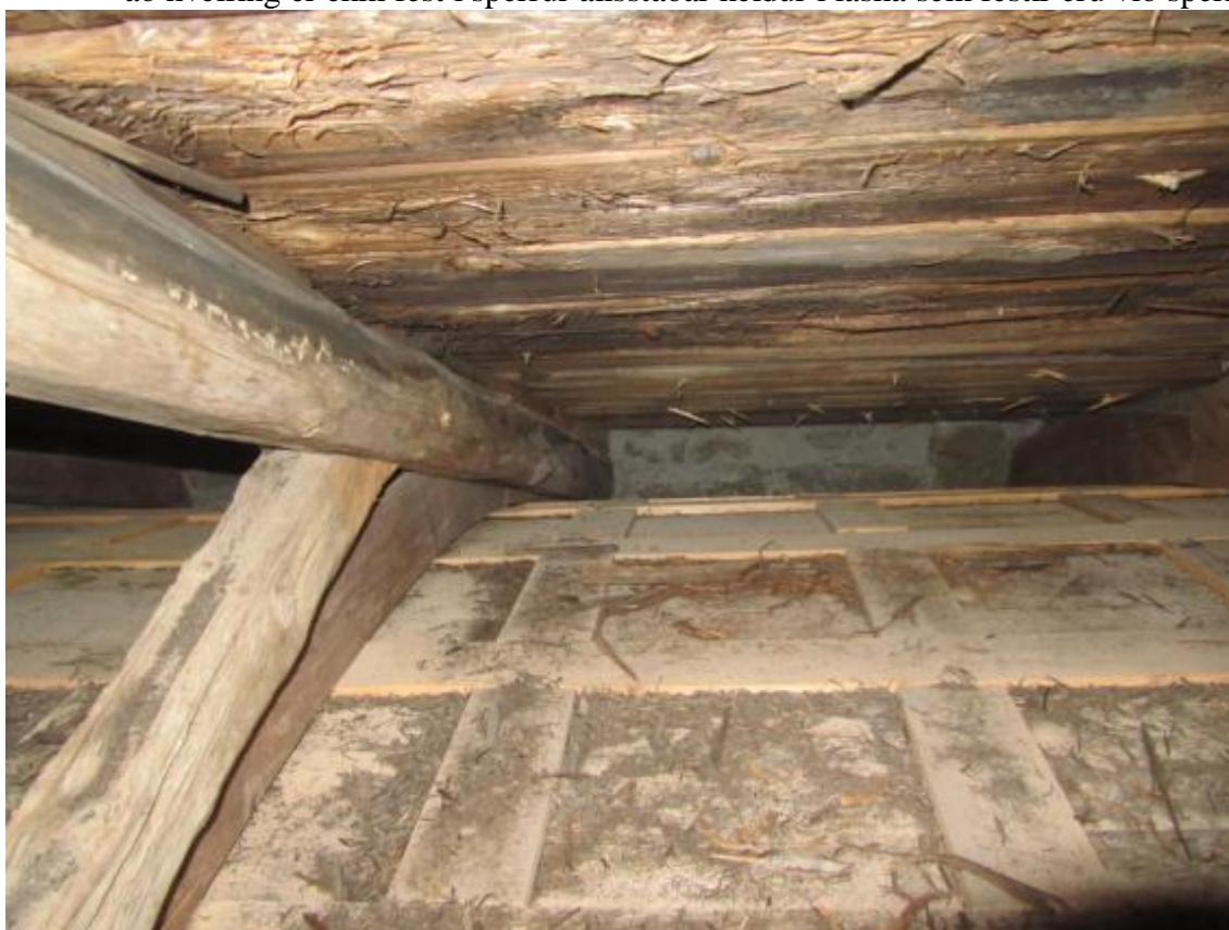
Mynd 6 Hér má sjá að lofthvelving er fest í laska sem festir eru á sperrur en líklegt er að fest sé í sperrur og skambbita þar sem það hefur verið hægt.
