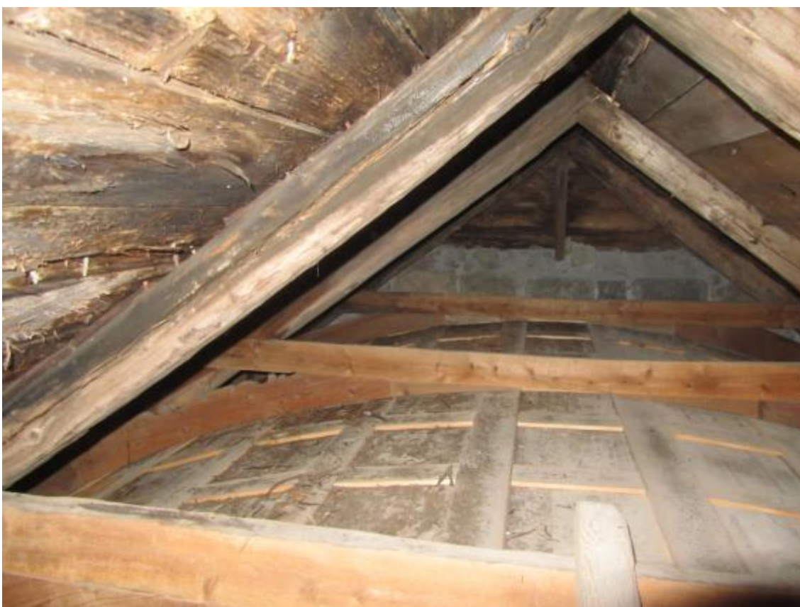
Mynd 2 Hér sjást 4. 5. og 6. sperra frá vestri. Mikill fúi er í efri hluta þaksins.
