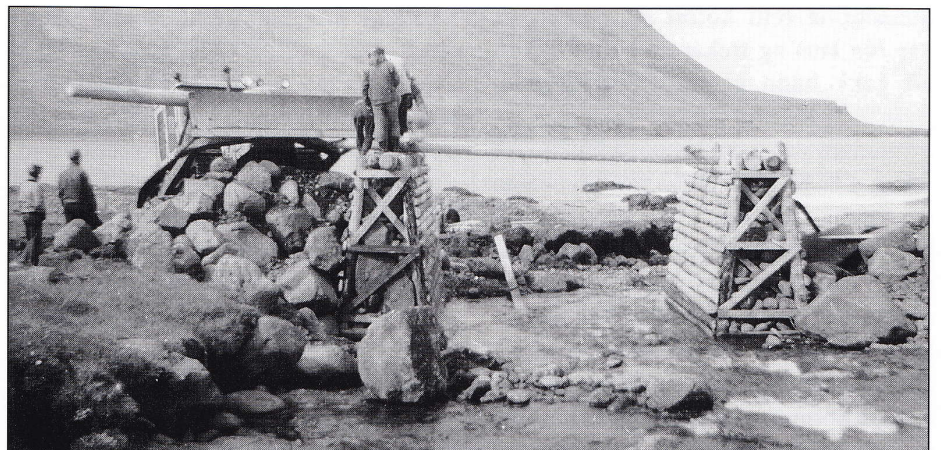
Brúargerð við Skarfadalsá á Strandavegi í Veðileysufirði árið 1966. Ýtan kemur með tré til að leggja á milli grjótkláfanna.
