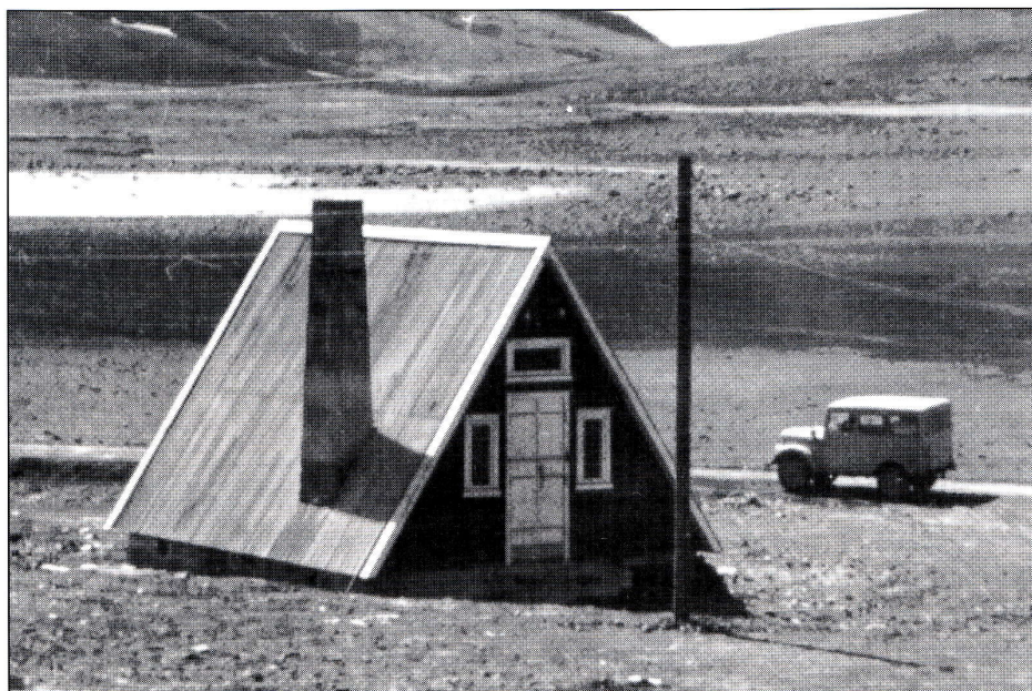
Sæluhúsið í Kerlingarskarði á Stykkishólmsvegi. Jón Víðis teiknaði þessi A-laga sæluhús sem Vegagerðin reisti á nokkrum stöðum.
