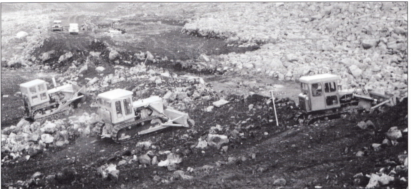
Vestfjarðavegur hjá Botnshesti árið 1959. Fjórar ýtur að vinnu.
