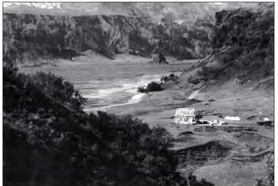
Sæluhús Ferðafélagsins í Langadal í Þórsmörk í byggingu árið 1954.
