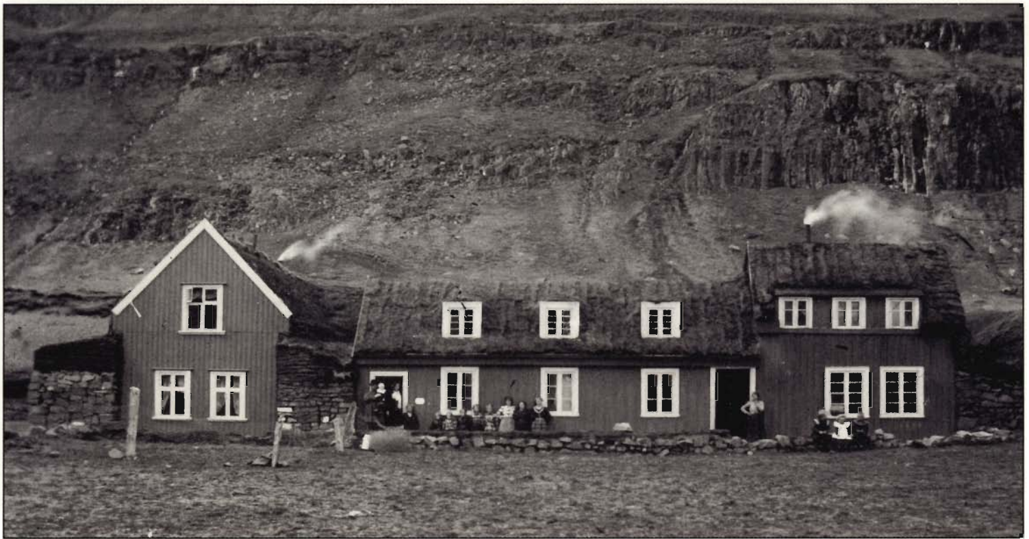
Ljósmynd af Valþjófsstaðabænum nokkru eftir aldamótin 1900, tekin af Vigfúsi Sigurðssyni á Egilsstöðum í Fljótisdal. Eigandi myndar: Ljósmyndasafn Austurlands.
